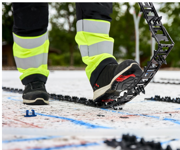
LK Putkipidikelista Combi 16/20 EPS-eristeen päällä.
