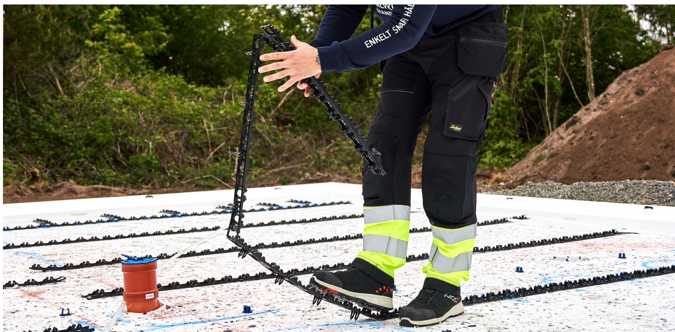
LVI-asentaja taittaa auki ja asentaa listan EPS-eristeen päälle.
